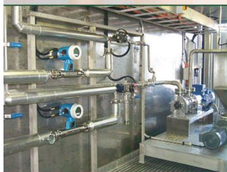
Модуль смешения эмульсионной матрицы с использованием динамического миксера закрытого типа.
